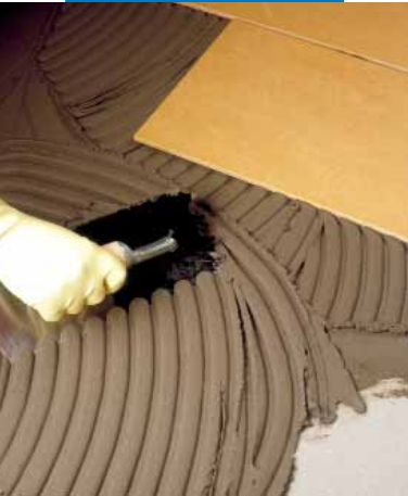
Elastorapid feldolgozása fogazott simítóval cementkötésű esztrichre
