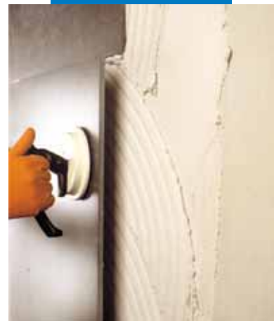
Nagyméretű kőporcelán burkolólapok ragasztása Elastorapid-dal beton homlokzatra
